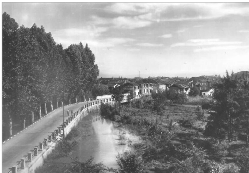
1955 San Giorgio di Nogaro: Via Aquileia - Il ponte sul fiume Corno
